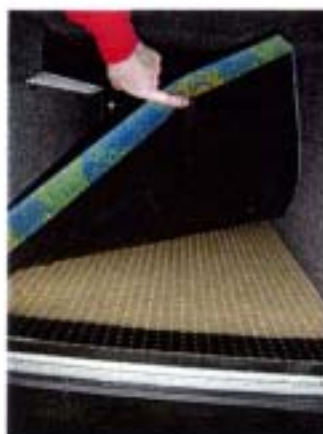
Figuur 3.13 Een matras met daaronder een geperforeerde boardbodem voor ventilatie. Het lijkt er echter op dat de onderzijde van de matras weinig vocht door kan laten
